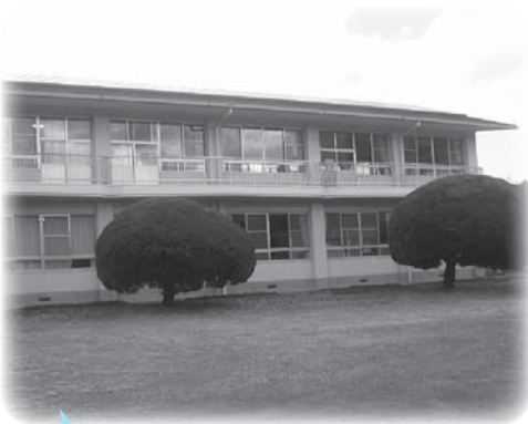
中学校改修工事費【632万円】
