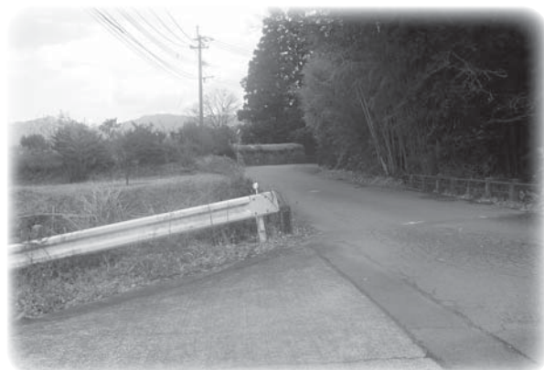
劣化し、危険な状態の橋
