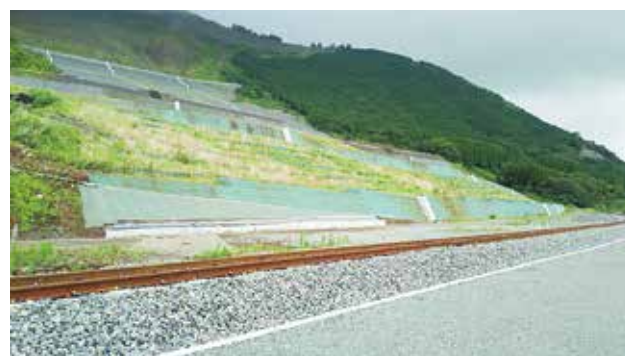
JR 大規模崩落地付近の復旧状況
