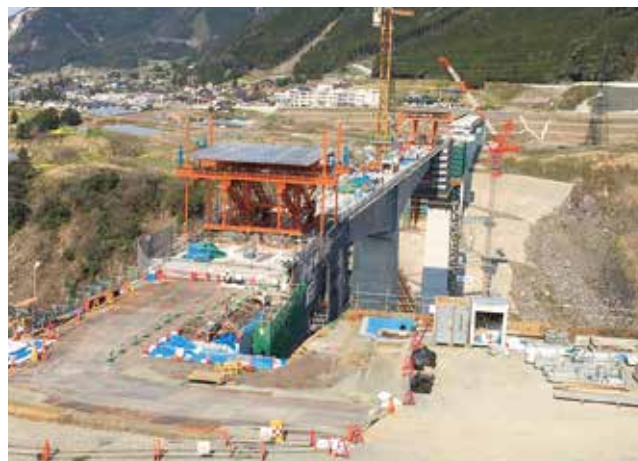
公募を提案したい工事中の新阿蘇大橋（仮称）
