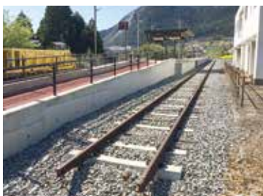
復旧が進む豊肥線
