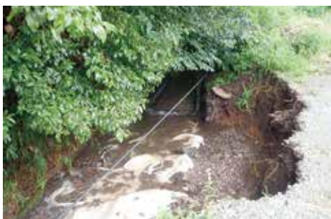
補修後、通水が待たれる立野水路
