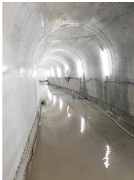
活用が期待される立野ダムの上段リムトンネル（高さ3.5m 幅3.0m 長さ380m）
