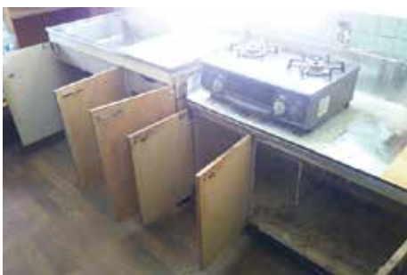
キッチン改修前
