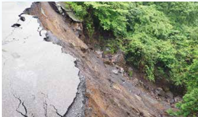
農業用施設災害復旧工事（平成長野大橋） 2874万円
