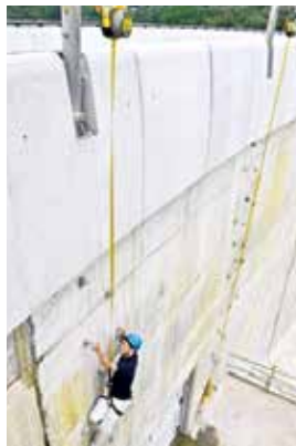
地元自治体が設置したクライミング
