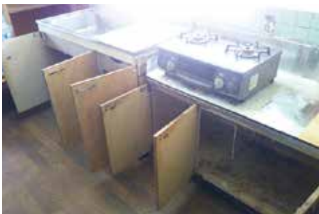
キッチン改修前
