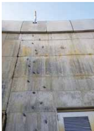
横瀬川ダムに設置されてるクライミング施設
