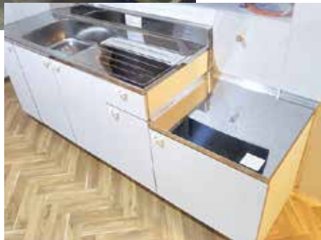
キッチン改修後
