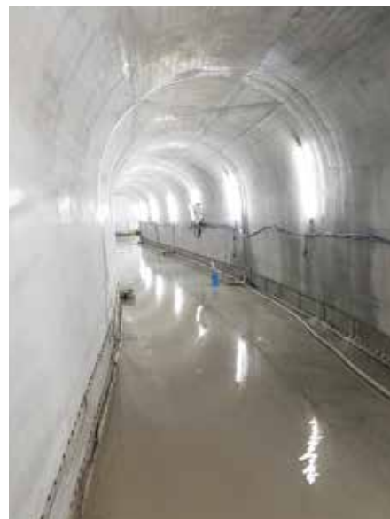
活用が期待される立野ダムの上段リムトンネル（高さ3.5m 幅3.0m 長さ380m）
