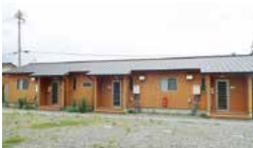
下野山田の木造仮設住宅
