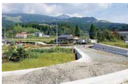
小規模住宅地区等改良工事 (6億7485万円)
