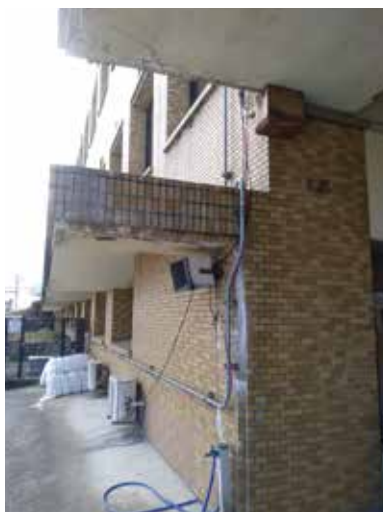
旧久木野庁舎改修工事費（外壁）
