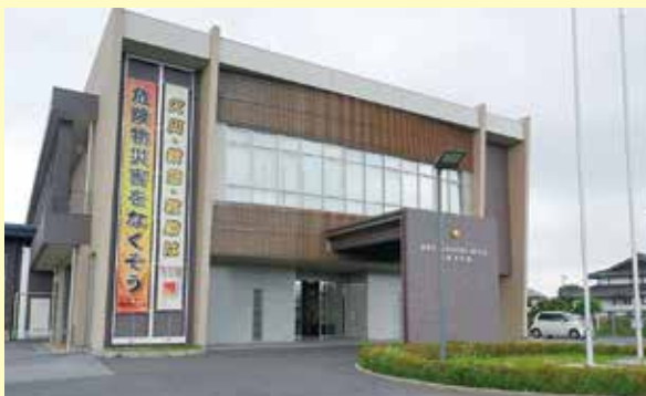
(説明) ①消防車両 ②通信指令室 ③防火更衣室
