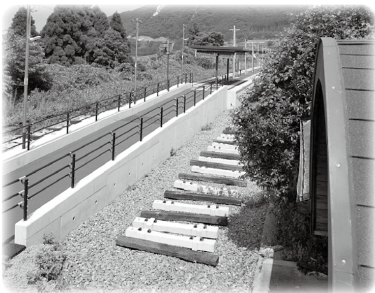
改修を終えたJR立野駅ホーム
