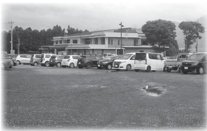
未舗装の西側駐車場
