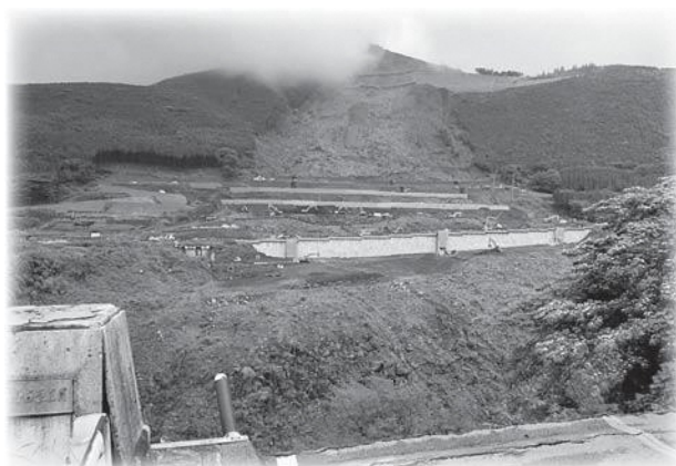
大規模崩落現場の復旧状況
