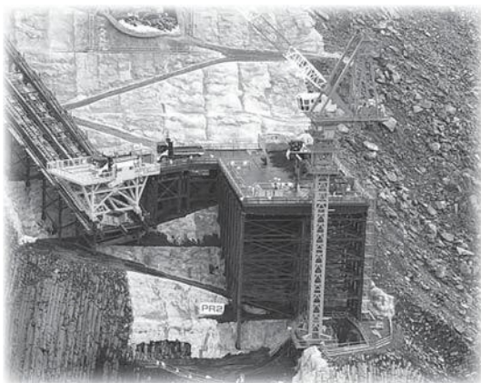
右岸側仮設備状況
