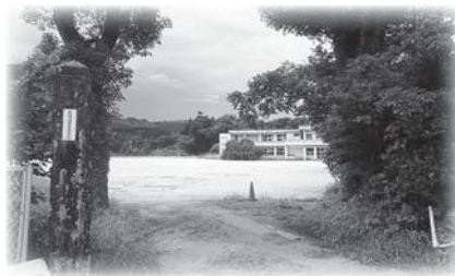
災害公営住宅予定地（旧西部小）
