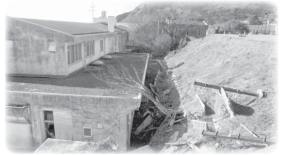
広域避難所としての防災対策工事を実施する(旧立野小学校)
