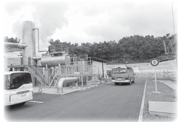
大分県玖珠郡九重町菅原 菅原バイナリー発電所 出力5,000kW、発電量4千万 kWh/年（一般家庭約11,000戸分の年間使用電力量に相当）
