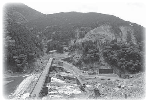
震災後の立野ダムの現状
