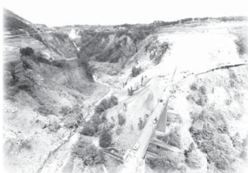
開通に向け作業が進む長陽大橋
