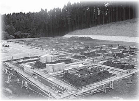
建設が進む長陽地区統合保育所
