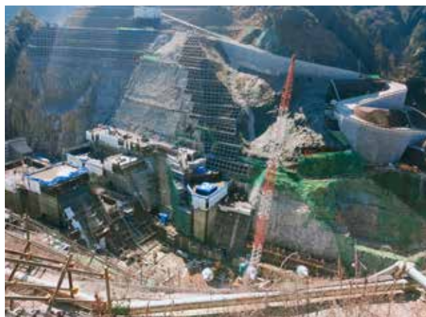
ダム本体コンクリート打設 進捗率40%
