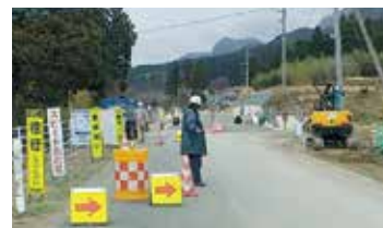
工事中の県道28号熊本高森線
