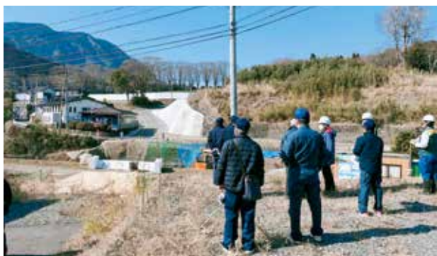
黒川区 小規模住宅改良事業 建設課 床瀬橋下部工工事 令和4年6月完成予定
