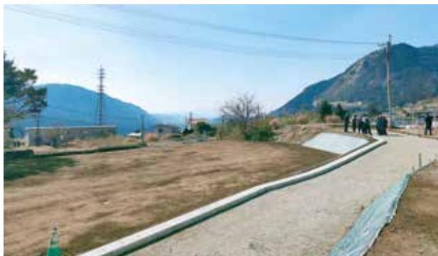
立野駅区造成工事 定住促進課 復興支援住宅新設 令和4年8月完成予定
