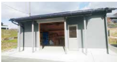
役場敷地内災害用備蓄倉庫
