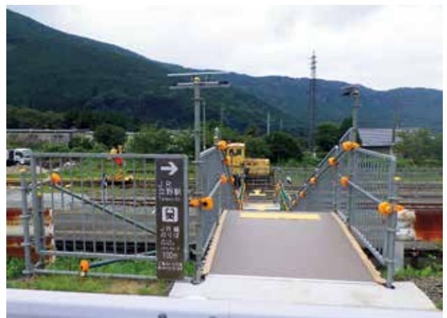
立野駅に設置した跨線橋
