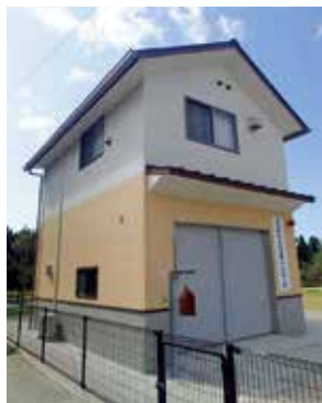
沢津野区消防詰所 (令和元年度完成)
