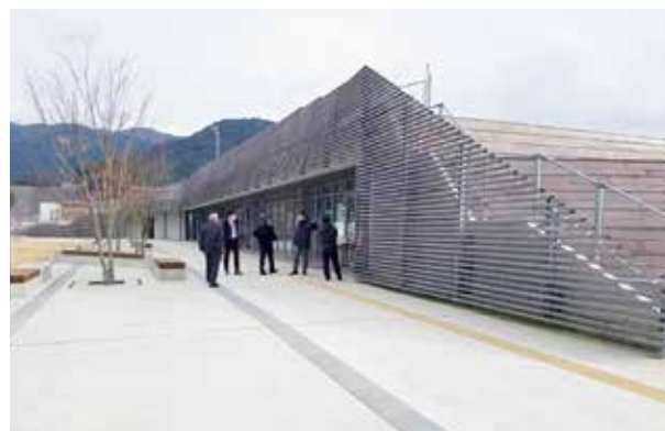
写真右側の階段をあがると展望デッキへ。ダム湖全体が見渡せる
