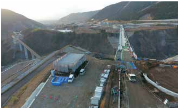
展望所広場に建設中の交流館
